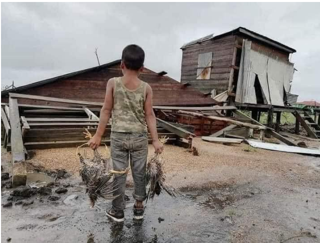
Zerstörte Häuser und Straßen im Department Cortés in Honduras, Quelle: Kevhin Ramos
