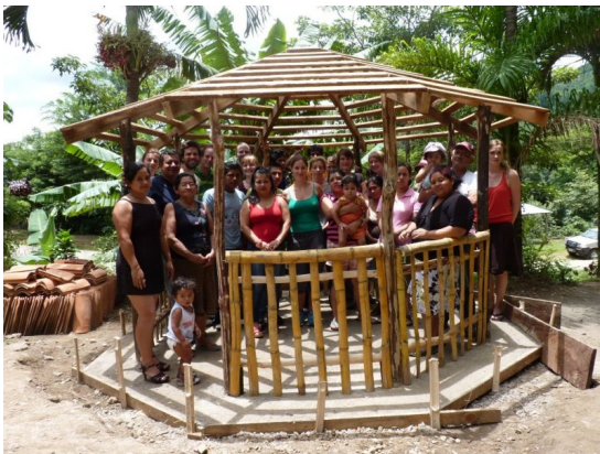
Nach fünf Tagen Bauzeit fehlt nur noch das Dach Foto: Karina Lange
