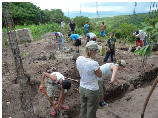
Baustelle in El Bocón Foto: Angela Mischke
