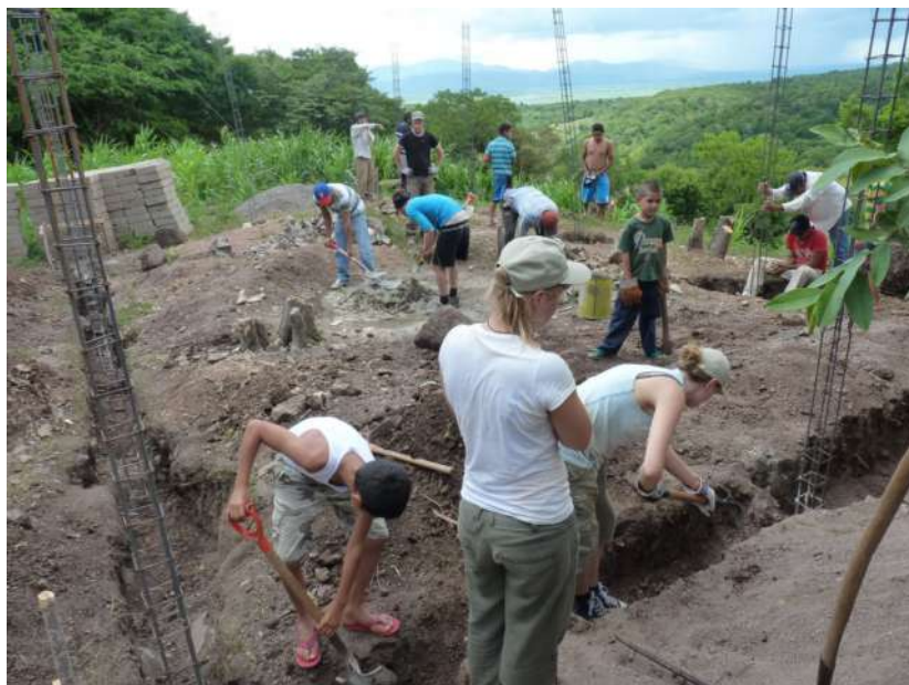
Auf der Baustelle in El Bocón
